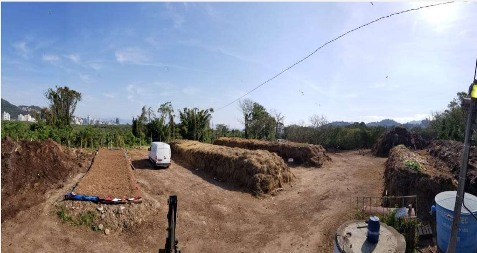
Leiras de Compostagem Estáticas, Termofílicas e de Aeração Passiva
